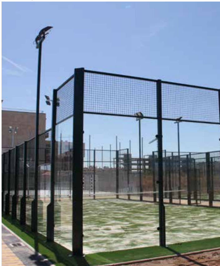
> Terrain de Padel - parois verre sécurité 10 mm et grille avec barres de cadrage des panneaux
