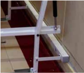
Poutrelle support basse fixée au mur de section 50 x 50 m. Les tribunes sont fixées sur ces poutrelles.
