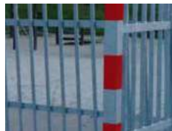
• Filets en tube acier galvanisé à chaud ø32 mm
