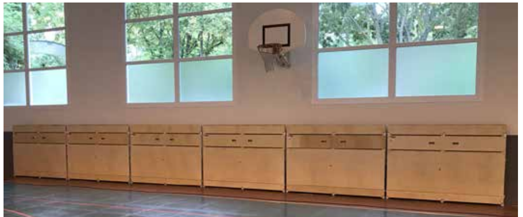
Panneaux de façade en contreplaqué 8 mm classé au feu M2. Repliée la tribune laisse un surface lisse sans aspérités. En partie basse une trappe de visite permet de récupérer d'éventuels objets tombés. Tous bords arrondis et chanfreinés.
