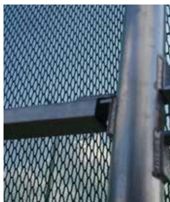
Platines de fixation des barres de liaison.
