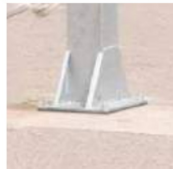
> Platine de poteau avec 4 points de fixations
