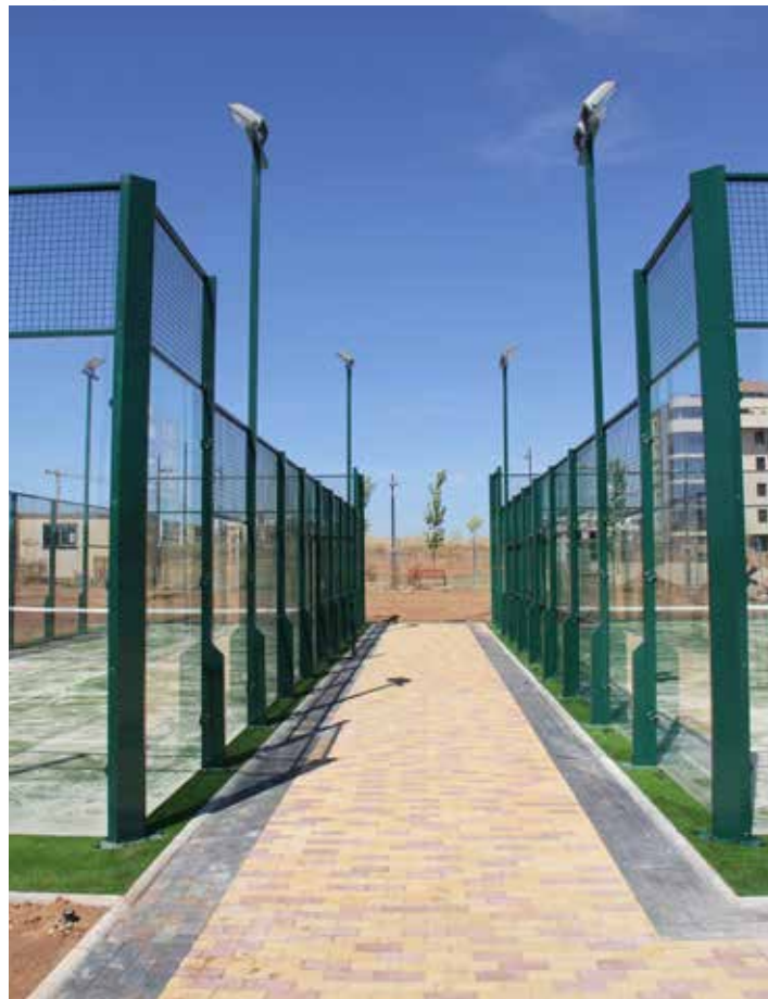
> Système d'éclairage à 8 projecteurs puissance 400 watts montés sur poteaux hauteur 6 ml
