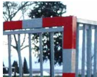
• Façade acier galvanisé coins soudés
