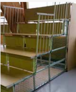
Protection latérale souple rétractable en filet mailles 45 x 45 mm
